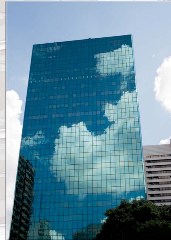
Edifício corporativo (São Paulo, SP): fachada envidraçada tipo "pele de vidro".
